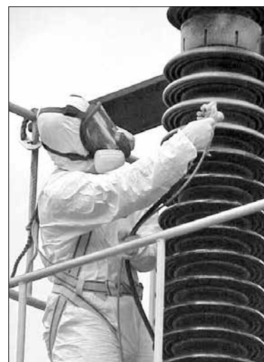
شکل ۶ - اعمال پوشش سیلیکونی آب گریز
