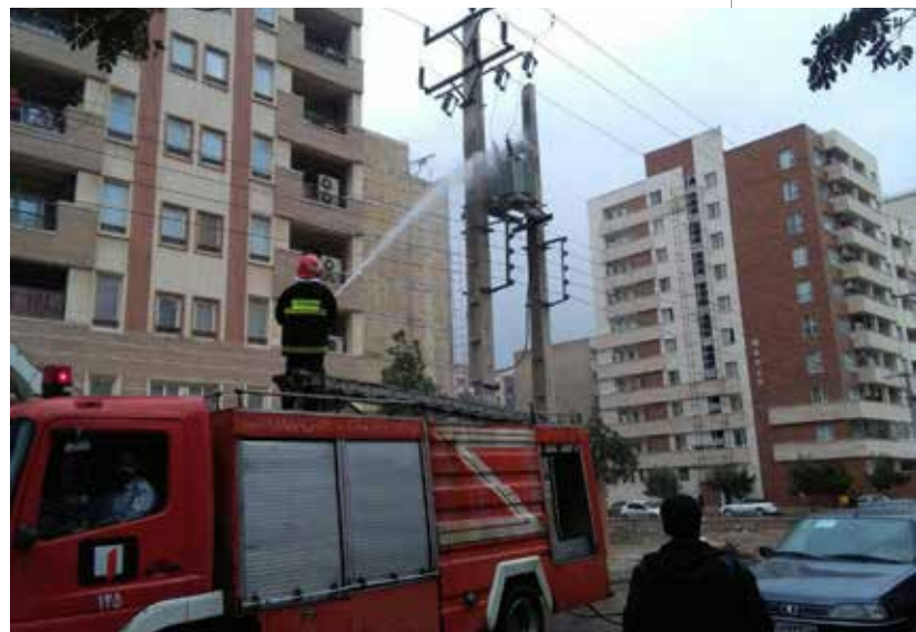
شکل ۳ - شستشوی پوششنگ ترانسهای توزیع
