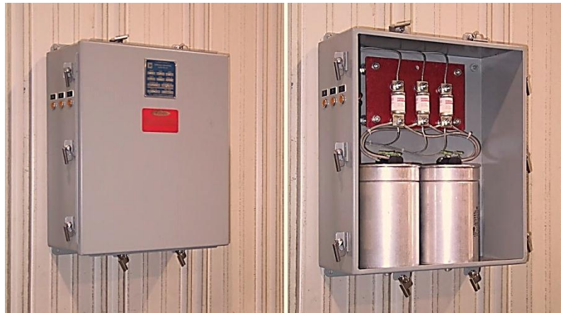
شکل ۱۵- نمونه‌ای از بانک خازنی
