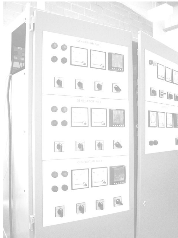
شکل (۱۴): نمایی از تجهیزات اندازه‌گیری نصب شده بر روی تابلو
